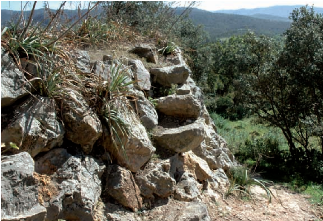
Figura 216. Escalera de piedra inserta en el "cintell" del horno de cal de Son Hortolà.
