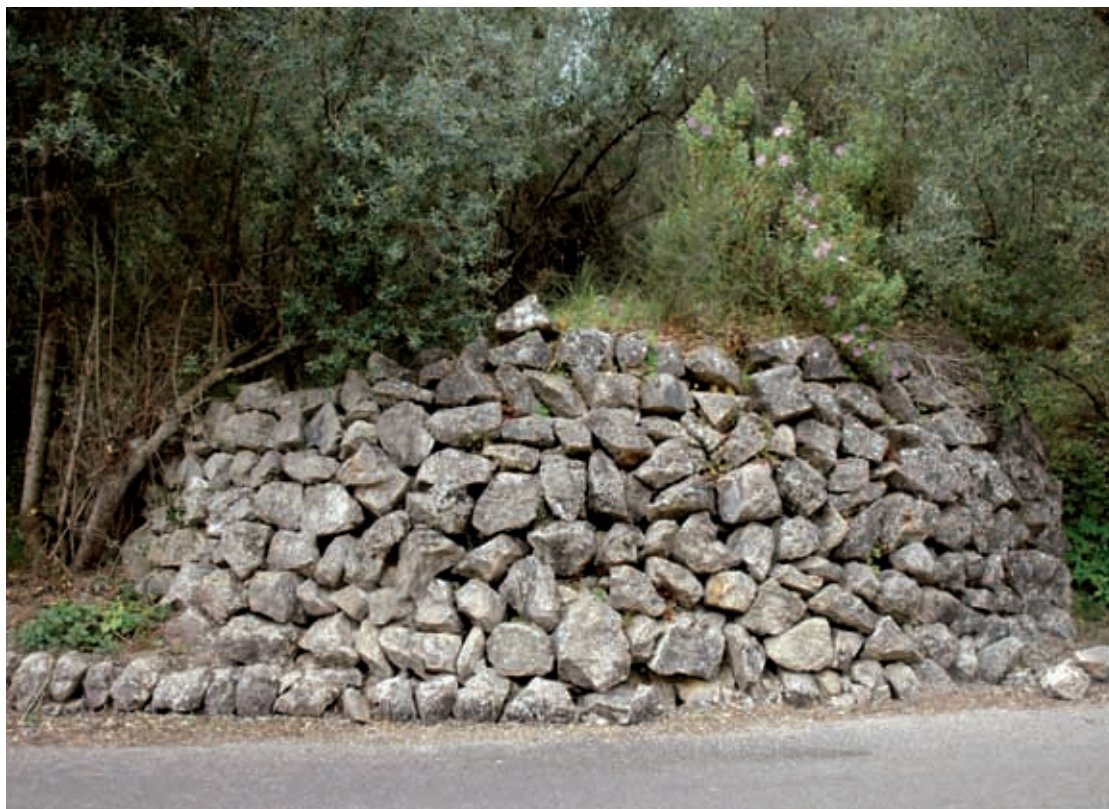
Figura 215. "Cintell" del horno de cal des Torrent del Pas de sa Mula.
