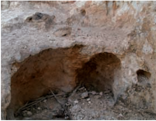
Figura 221. Horno de cal de sa Cova de Son Boronat, que aún conserva cal en su interior procedente de la última hornada.
