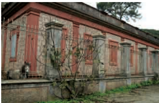
Figura 283. Polvorín ubicado a la entrada del recinto.
