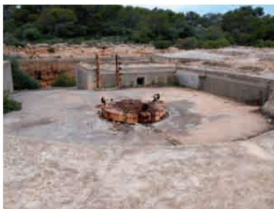
Figura 275. Anclaje de una de las piezas de artillería actualmente desmantelada. Al fondo puede observarse el soporte utilizado para colocar los proyectiles.
