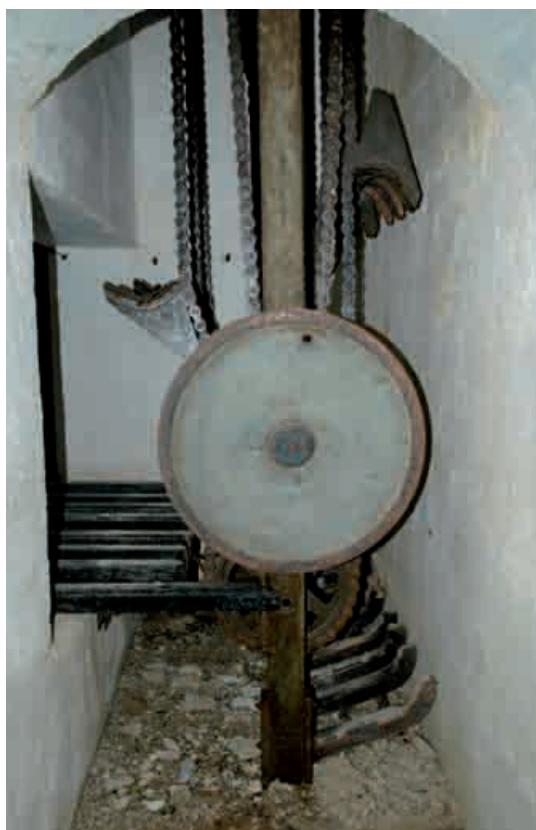
Figura 273. Montacargas electromecánico con cadenas y cangilones del Banco de Ibiza.
