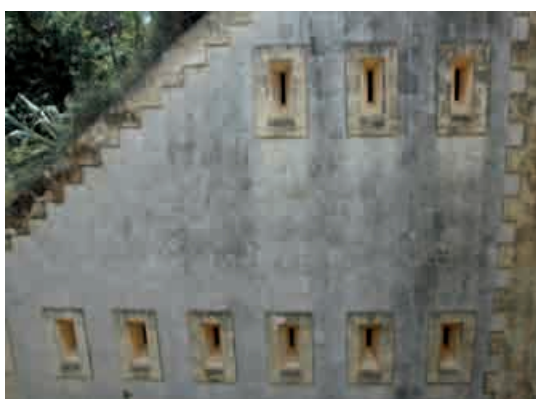
Figura 281. Muro del foso con aspilleras en la zona de acceso al interior del fortín.
