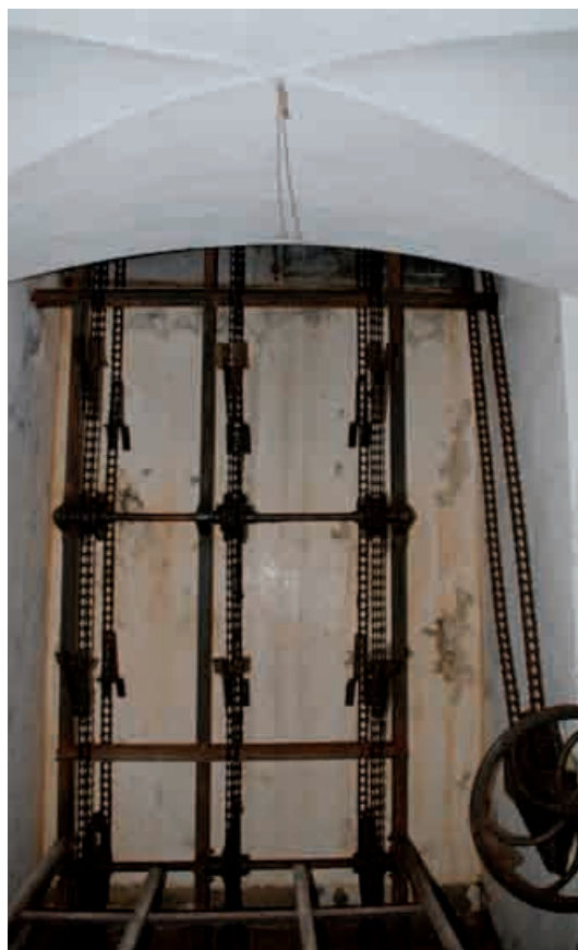
Figura 276. Elevador electromecánico para transportar los proyectiles desde el almacén a la pieza de artillería.
