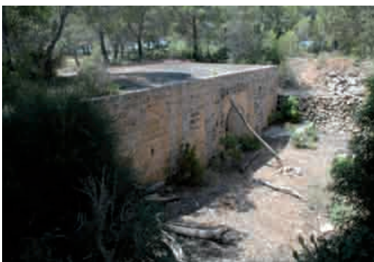
Figura 262. Exterior de la sala de repuestos.
