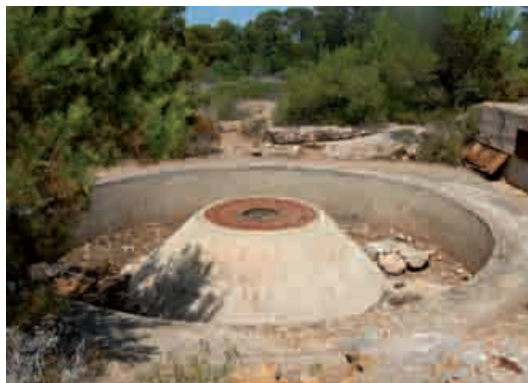
Figura 270. Banco de Ibiza. Estructura de hormigón con anclaje para pieza de artillería y escotilla para proyectiles cubierta con puertas metálicas.
