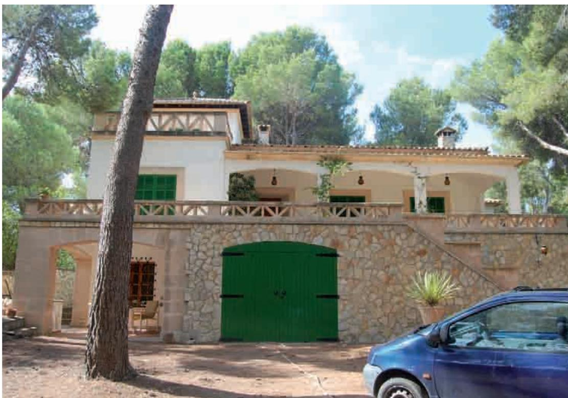
Figura 357. Vivienda situada en la Avenida de la Cruz nº 23, en la que se pueden observar dos espacios abiertos y cubiertos por porches que se sustentan mediante arcos escarzanos y pilares.
