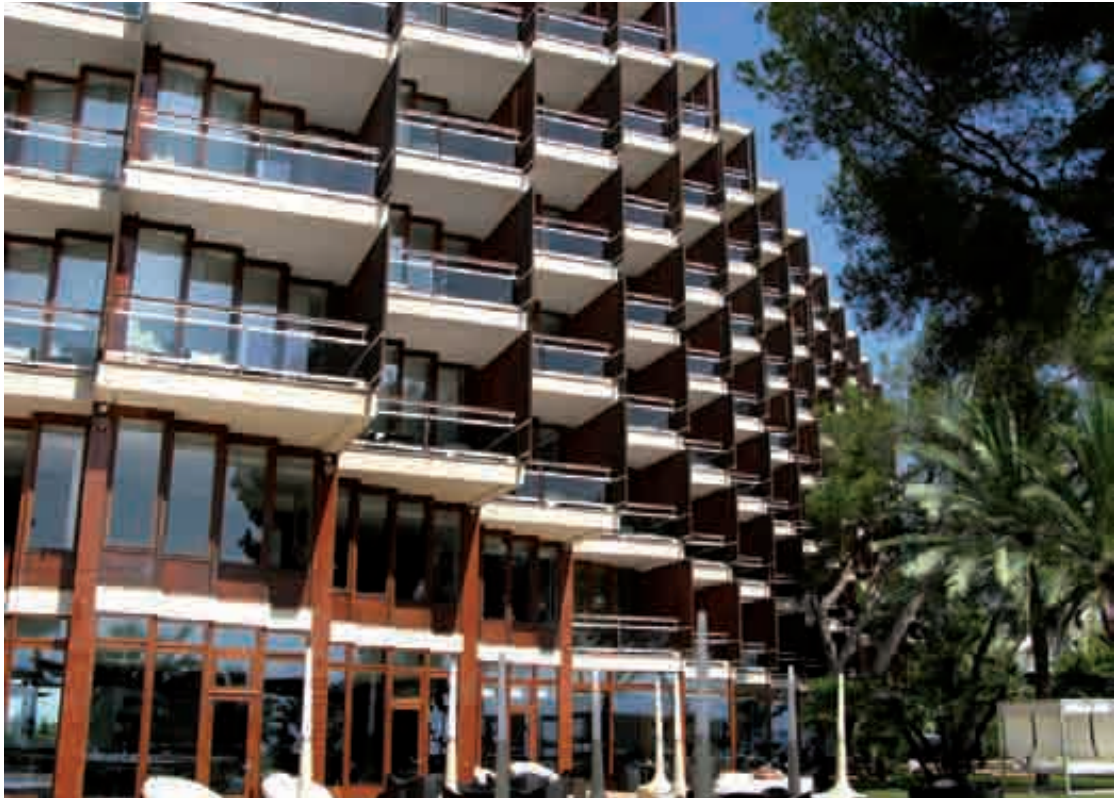
Figura 317. Fachada marítima del hotel del Mar.
