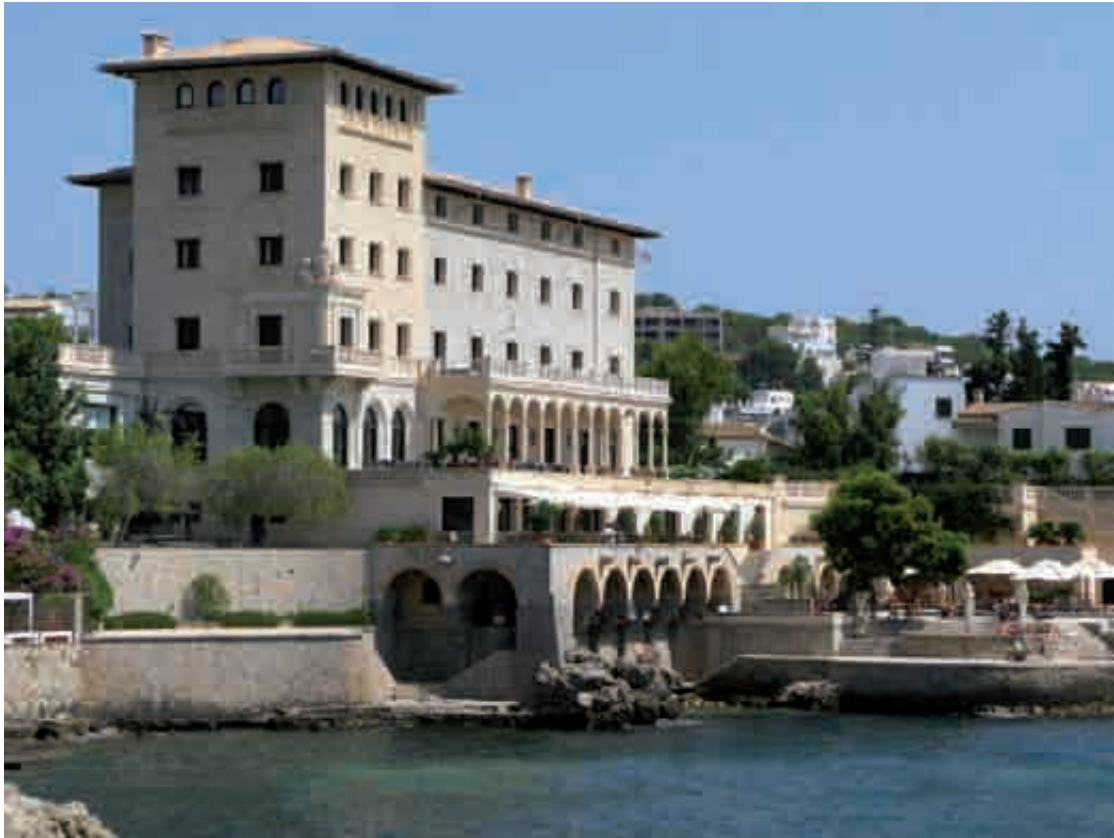
Figura 304. Fachada marítima del hotel Maricel.
