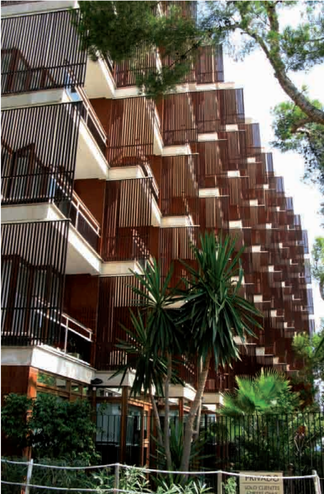
Figura 318. Lateral de la fachada, donde se aprecia el juego de separación mediante lamas de madera.
