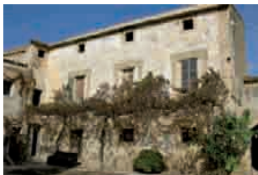
Figura 382. Cuerpo principal de la "possessió" de Ses Barraques, de planta longitudinal. Presenta una única crujía, cubierta a una vertiente hacia el interior del patio, tres plantas, y distribución simétrica de los vanos.
