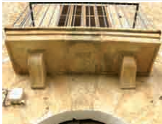
Figuras 389, 390. Fachada principal de Son Durí y balcón de la "possessió" de Son Durí, situado sobre el "portal forà" y sustentado sobre ménsulas de piedra, con la fecha de 1837 inscrita.
