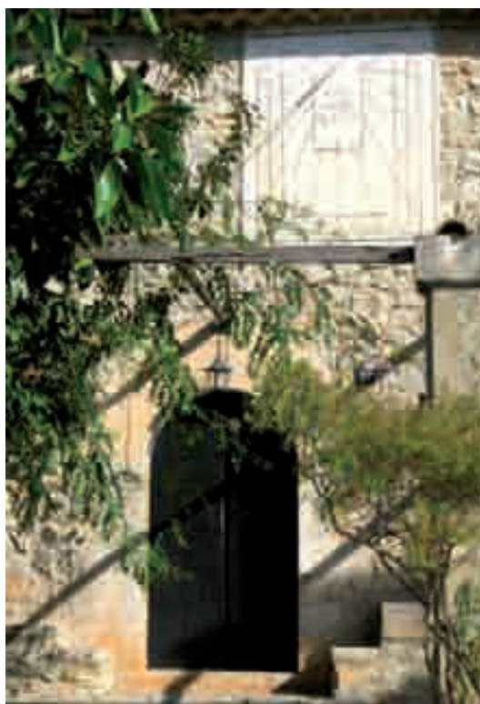
Figura 453. "Portal forà" de Sa Costeta que se encuentra flanqueado por dos bancos adosados acabados con dos escalones con función de "pujadors". La carrera delantera presenta una pérgola soportada sobre pilares. Encima del portal se conserva el reloj de sol con una inscripción.
