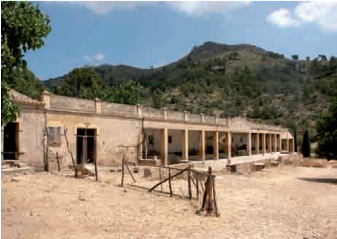
Figura 448. El ejemplo más peculiar de porquerizas lo encontramos en Galatzó, donde los muros aparecen decorados utilizando la misma técnica que en la fachada principal.
