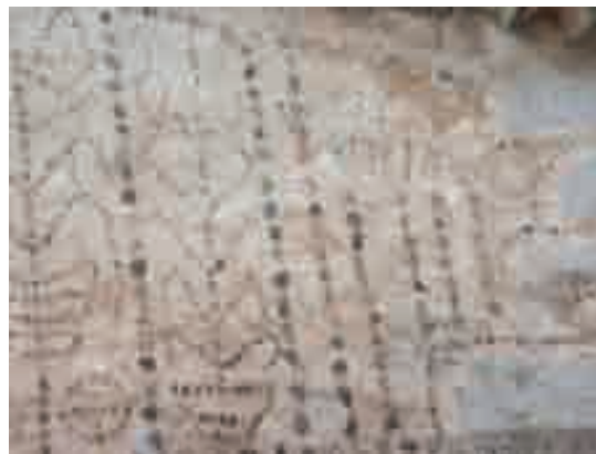
Figura 401. Detalle de la decoración de la fachada de Mofarés, realizada mediante la incrustación de cantos rodados en el enlucido húmedo.
