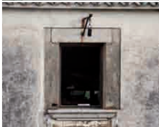
Figuras 418, 419, 420. Casas de Mofarés. Desde el exterior, se puede observar un cuerpo principal de tres plantas: la primera se destina a dependencias agropecuarias, en la segunda se sitúa la planta noble con una terraza sustentada mediante pilares y una buhardilla en la tercera planta, dedicada a almacén. Una vez en el interior del patio, se observa la escalera que da paso a la segunda planta del cuerpo lateral, que conectaría con el principal, y en la tercera planta se observa una polea en relación con un vano, que podría tratarse del "sostre de la palla".
