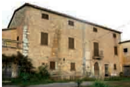
Figura 387. Fachada de la "possessió" de Peguera, en la que se aprecian cuerpos de diferente altura, con vanos de tamaño dispar, y diferente tratamiento de los acabados.
