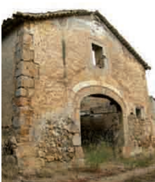
Figura 450. Edificio de Son Martí identificado como vaqueriza.
