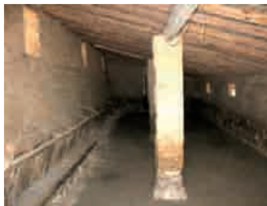
Figura 451. Sesteaderos de Son Vic Nou, de planta longitudinal, de una única planta y a una vertiente, sustentada sobre pilares situados en el centro de la nave; en el lateral se han dispuesto los comederos.
