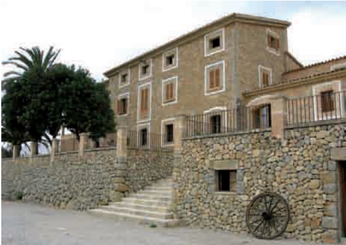
Figura 454. Cuerpo principal de Son Estades, al que se accede mediante una escalera. Se aprecian todos los vanos alineados y enmarcados por una franja blanca.
