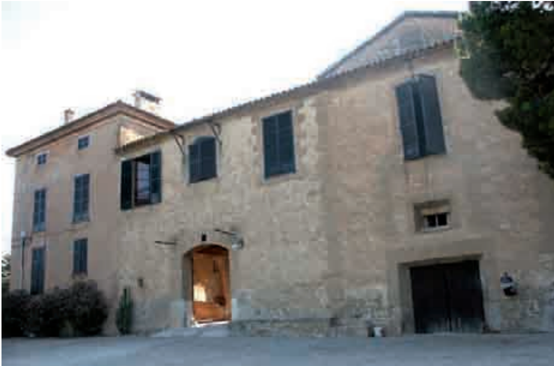
Figura 387. Fachada de la "possessió" de Peguera, en la que se aprecian cuerpos de diferente altura, con vanos de tamaño dispar, y diferente tratamiento de los acabados.
