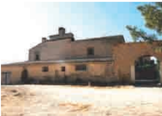
Figura 388. Fachada de la "possessió" de Ses Barraques, en la que se aprecia la disposición de cuerpos de diferentes alturas y alternancia de volúmenes.
