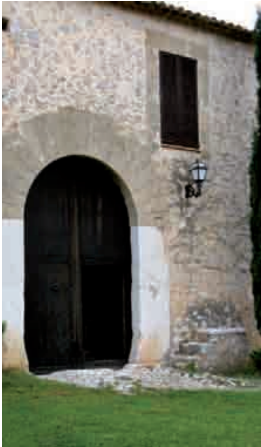
Figura 398. En el lateral derecho de la fachada de Ses Algorfes encontramos un ejemplo de "pujador" de tres escalones.
