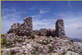
Caseta de Aragó
