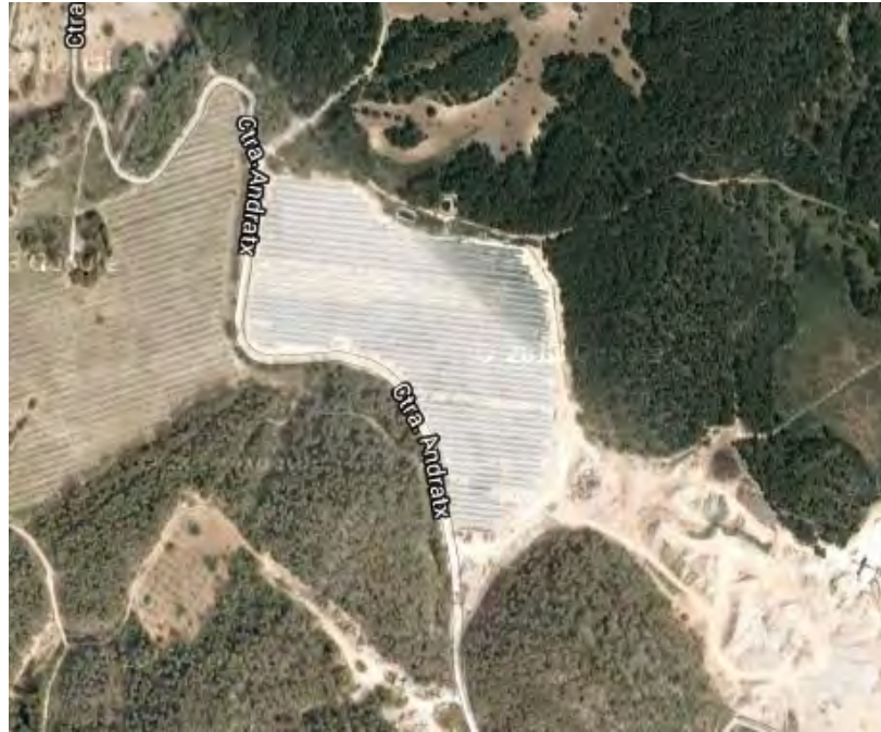
Imatge 2. Foto aèria del parc fotovoltaic de ses Barraques
