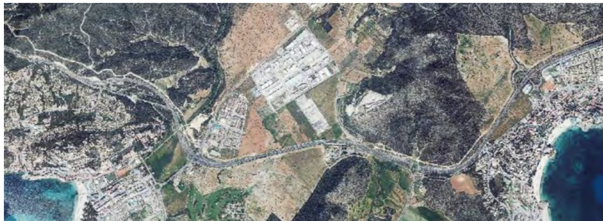
Fotografia aèria de 2015 que mostra el tall del territori que provoca aquesta infraestructura (font: IDEIB)
