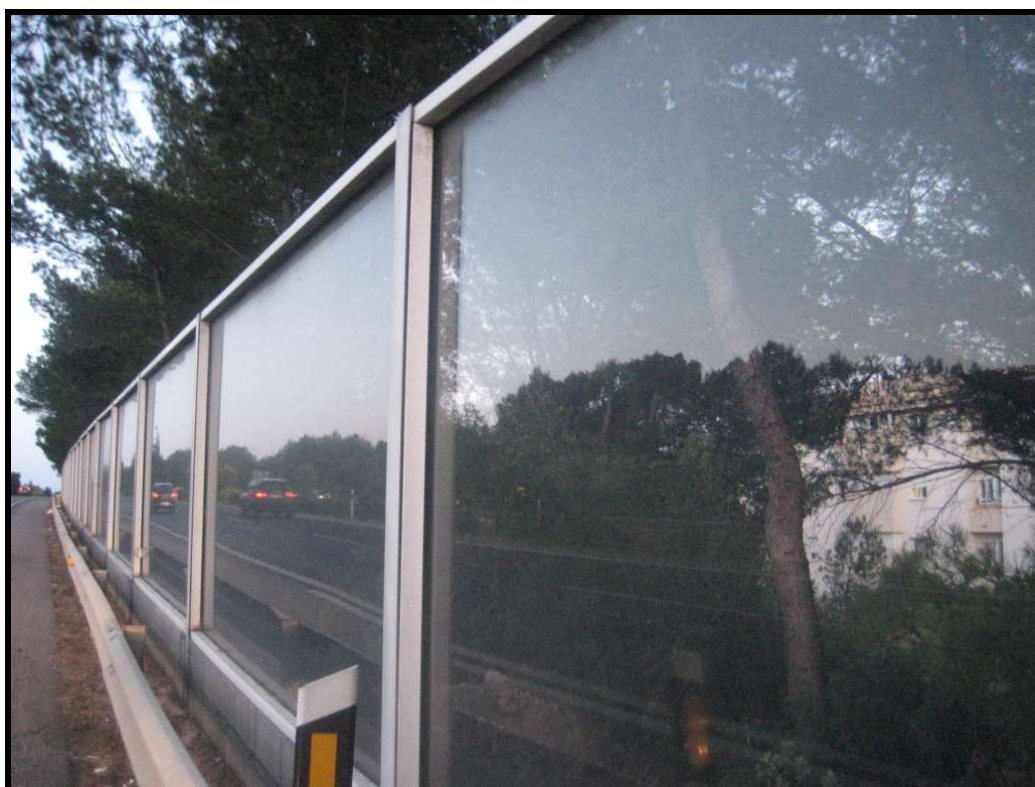
Pantalles de metacrilat instal·lades pròximes a Costa d'en Blanes a la Autovia Ma-1
