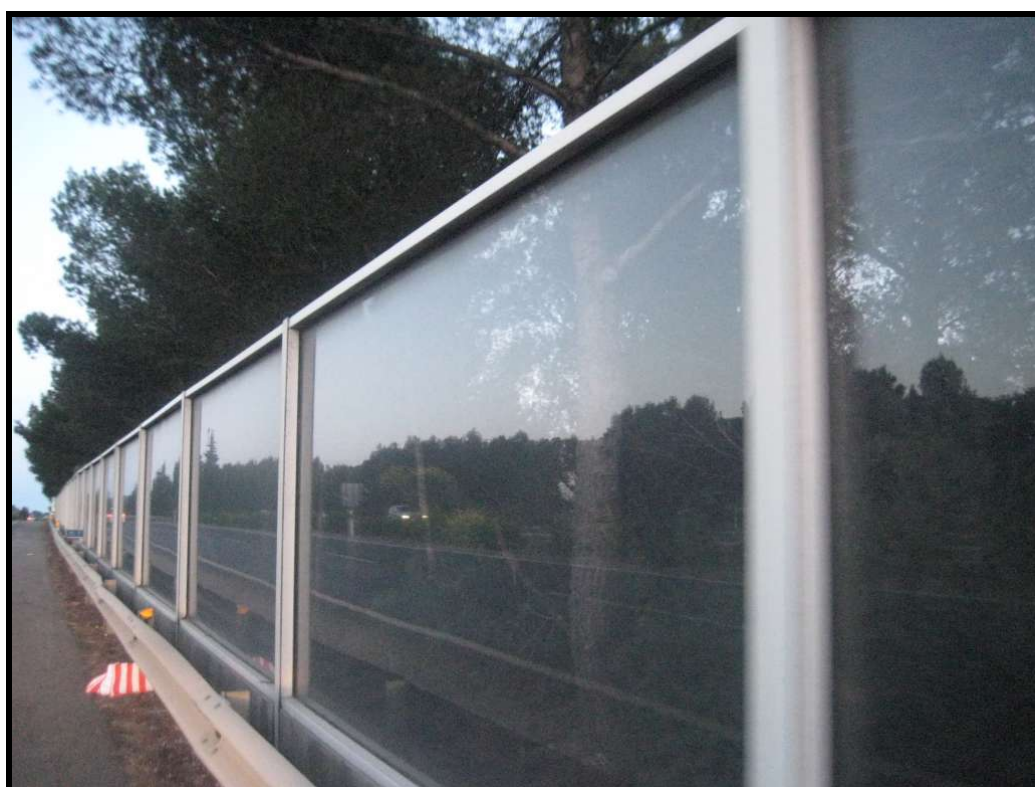
Pantalles de metacrilat instal·lades pròximes a Costa d'en Blanes a la Autovia Ma-1
