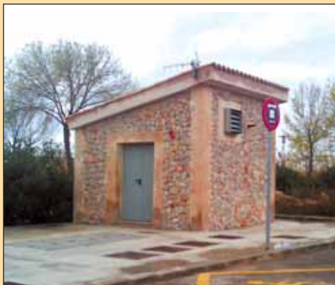
Nuova stazione di trattamento delle acque reflue.
