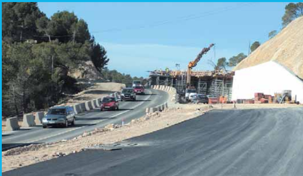
Las obras del desdoblamiento Palmanova-Peguera marchan a buen ritmo.
