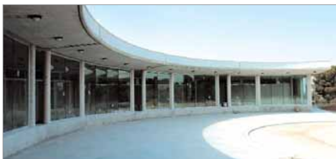
Las obras del nuevo centro se encuentran en su fase final.
