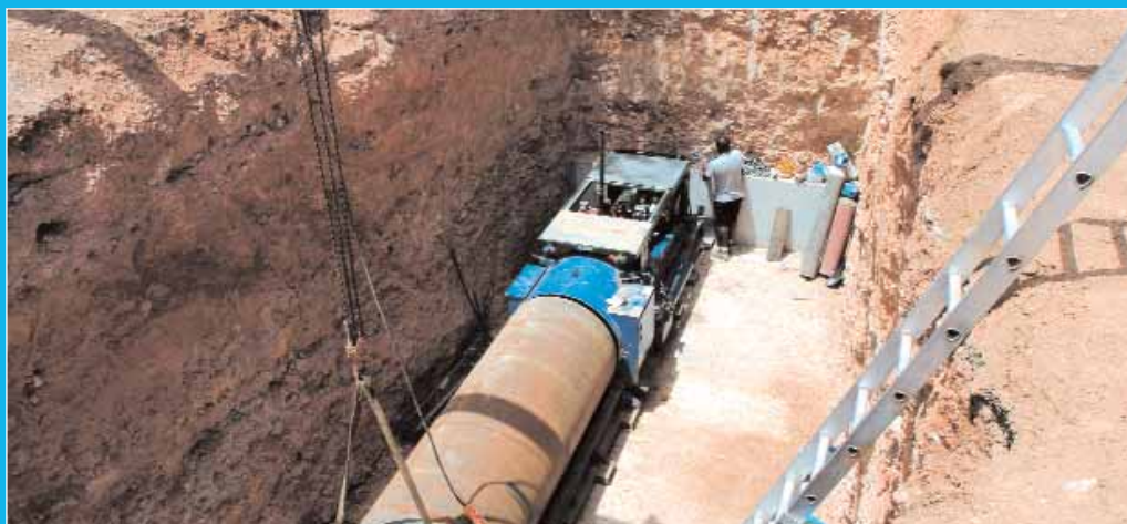
Una màquina perforadora evita haver d'obrir el carrer durant l'estiu.
