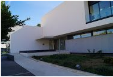
JUDAS ARRIETA: Polideportivo de Peguera
