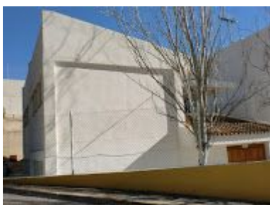
GRIP FACE: Instalaciones frontón de Peguera
