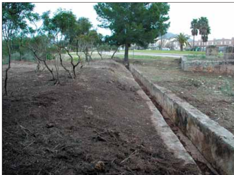
Tareas de recuperación en el aljibe de la urbanización Galatzó.
