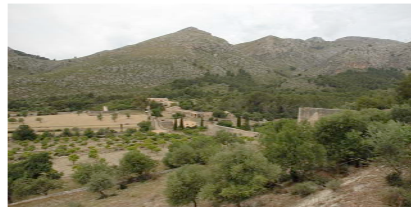
Sistema hidráulico de Galatzó
