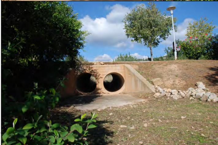
Obras de fábrica bajo el Passeig Calvià. El PPO prevé una solución técnica adecuada para el drenaje.
