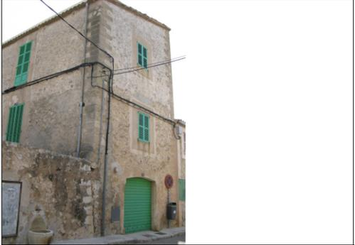
Descripción: Fachada lateral que en lugar de tener dos alturas tiene tres, aprovechando la inferior como garaje al cual se accede através de un arco escarzano. Se pueden observar las señales y el cableado que no permite una correcta visión del edificio.
