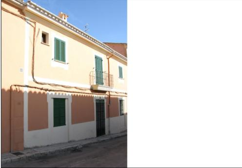
**Descripción:** La fachada está enlucida y pintada de color tierra con una banda decorativa de color blanco que recorre los laterales, los vanos y el tercio inferior a modo de zócalo. En este se observan desperfectos causados por la humedad. El cableado y la bajante no distorsionan la visión de conjunto al estar pintadas igual que la fachada.
