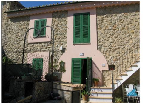
Descripción: Fachada principal con dos alturas con filas de vanos alineados. En el lateral tiene un cuerpo adosado con una escalera lateral que permite acceder al primer piso. Se pueden ver los muros de mampostería con vanos de arenisca que están enlucidos y pintados. El tramo central está destacado con el enlucido.
