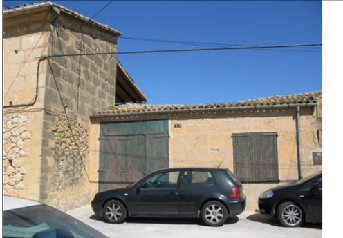
Descripción: Muro lateral de la vivienda que tiene adosado un garaje. En la planta baja el muro es de mampostería con las esquineras y vanos de arenisca. En la primera planta los muros son de sillares de arenisca. La cubierta es inclinada, de una vertiente con teja árabe.
