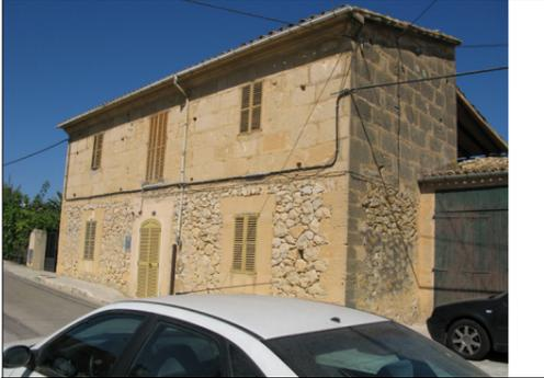
Descripción: Vivienda de planta longitudinal con dos plantas con filas de vanos alineados. En los extremos hay dos ventanas y en la zona central una puerta en la planta baja formada por un arco escarzano y una ventana el doble de grande que las laterales sobre la misma.
