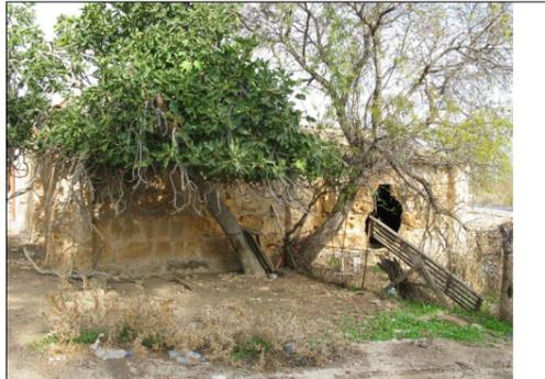
Descripción: Fachadas laterales. La primera corresponde a la fachada de la derecha, no tiene aberturas aunque han abierto un agujero para acceder al interior. La fachada del lateral izquierdo tiene una terraza en la parte frontal y a la que se accede desde la escalera lateral adosada al muro.
