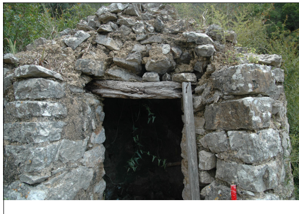
Descripción: Detalle de la cubierta y el vano del pozo.
