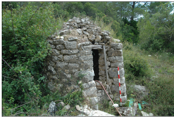
Descripción: Vista lateral del pozo.
