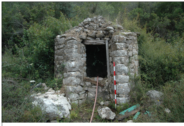
Descripción: Vista exterior del pozo.
