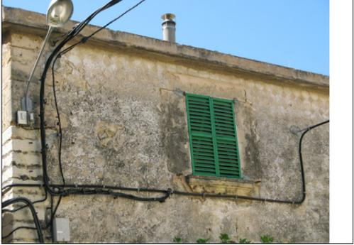
**Descripción:** El revestimiento del muro está en mal estado debido a la suciedad y a que está craquelado. Bajo la cornisa hay restos de decoración en mal estado de conservación. La suciedad recubre los muros. El cableado distorsiona la visión del conjunto.
