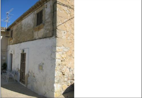
Descripción: Fachada principal que discurre de manera perpendicular a la calle principal. Tiene planta longitudinal y dos alturas con vanos no alineados. En la planta baja se localizan dos puertas, una adintelada y otra formada por un arco escarzano. En el primer piso dos ventanas adinteladas con alfeizar moldurado de arenisca. La planta baja está blanqueada pero se ha perdido ese revestimiento en el piso superior.
