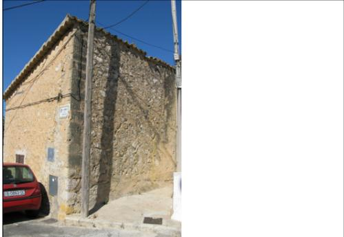
Descripción: Fachada lateral y posterior que sólo tienen una abertura en la planta baja de la planta baja. Permite ver la cubierta inclinada de una sola vertiente con teja árabe. También son visibles los muros de mampostería.
