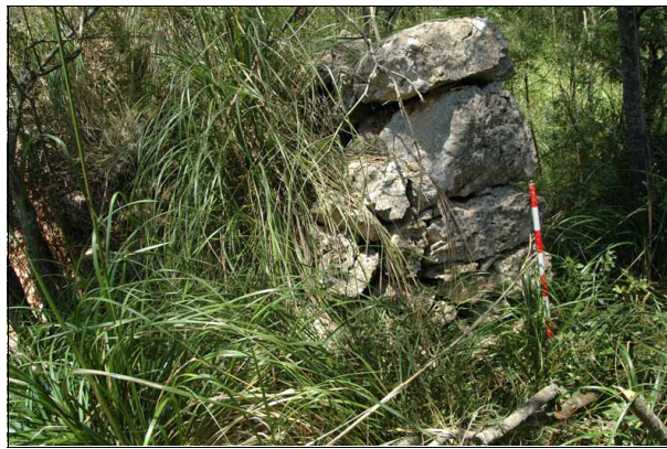
Descripción: 300-1: Detalle jamba izquierda de la boca del horno de cal.
