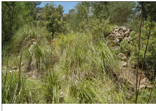
Descripción: 300-1: Vista exterior del horno de cal.
