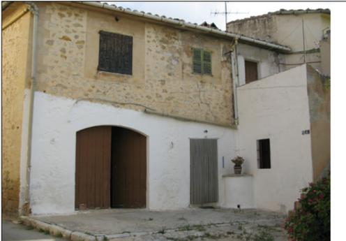
Descripción: Fachada posterior que presenta dos alturas. Las modificaciones y las adiciones a la fachada han variado los vanos de la misma. La planta baja consta de dos puertas, una adintelada y otra formada por un arco escarzado. Ésta cierra mediante puerta de madera de doble hoja. En el primer piso dos ventanas cuadradas de diferente tamaño y una puerta lateral.
