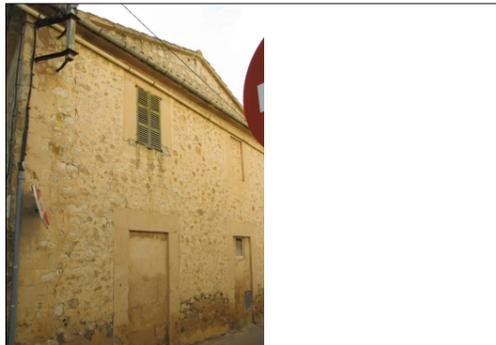
Descripción: Fachada lateral situada en c/ Sa Costa. Presenta dos alturas con vanos alineados. Des éstos sólo está abierta una ventana en el piso superior y un ventanuco en el piso inferior. Los muros son de mampostería, menos las esquineras y aperturas realizadas con arenisca. Presenta humedades en el tercio inferior. Se puede observar la cubierta a doble vertiente cubierta de teja árabe. También una cornisa.
