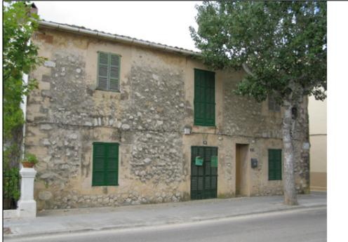
Descripción: Fachada principal situada en la Av. des Capdellà. Presenta dos alturas con vanos alineados excepto una puerta, construida entre dos vanos. Los muros son de mampostería, menos las esquineras y aperturas realizadas con arenisca.
