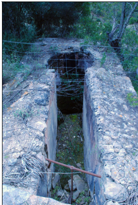
Descripción 149-5: Detalle de la canalización de desagüe desde el safareig hasta el cup del molino.
