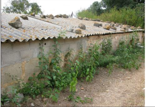
Descripción: Porqueriza de planta longitudinal con comederos situados a media altura. Los muros son de sillares de arenisca con una reparación realizada con bloques de hormigón. La cubierta de una vertiente con uralita.
