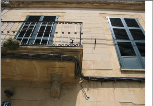
Descripción: Vista del piso superior que consta de dos ventanas rectangulares. La ventana de la izquierda tiene un balcón de piedra con verja de hierro forjado. El balcón se sujeta con dos ménsulas con decoración vegetal. Se observan humedades en el voladizo y grietas en la base del balcón.
