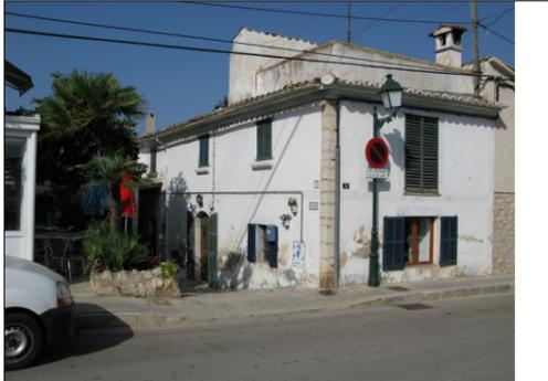
Descripción: Fachada principal y fachada exterior. Se puede observar una farola que distorsiona la visión completa del conjunto, los restos de pintura azul y los deterioros del tercio inferior
