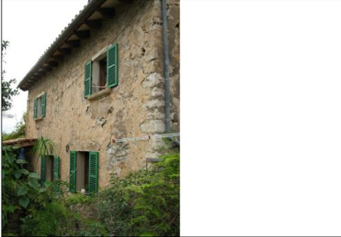
Fachada principal con dos vanos en la planta superior con alfeizar de marés moldurado. La cubierta es inclinada con voladizo sobresaliente. Los muros son de mampostería enlucidos. El revestimiento está deteriorado, se han perdido algunas zonas y hay grietas.
