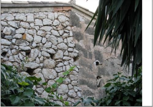
Descripción: Tratamiento diferenciado de las diferentes partes del muro, con la mampostería vista en el lateral izquierdo y revestido en el derecho. Sobre la pérgola se conservan algunas de las vigas antiguas, que fueron substituidas debido a su alto estado de degradación.
