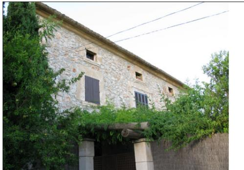
Descripción: Fachada principal dividida en tres pisos. La planta baja, a la que se accede mediante escalones presenta tres vanos, dos ventanas laterales y una puerta formada por un arco de medio punto. Esta planta está cubierta por un porche formado con troncos de madera que se sostienen sobre pilares de marés.
