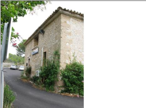
Descripción: La fachada del lateral izquierdo tiene dos alturas con dos vanos en la planta baja y uno en la superior colocado entre los anteriores. Hay vegetación adosada a los muros y un aparato de aire acondicionado con canaleta de plástico para cubrir el cableado que distorsiona la visión de conjunto. Los muros son de mampostería con esquineras y vanos de marés.
