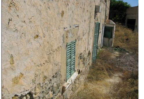
Descripción: Vista de la planta baja de la fachada principal. Está en estado de abandono, ha perdido parte del revestimiento del muro y la vegetación invade el recinto. Tiene un cuello de cisterna cuadrado adosado al muro que está cubierto con una estructura que continúa el cuello de la misma.
