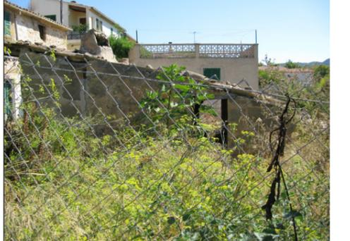
Descripción: Habitáculo construido frente a la casa, que servía de almacén y que viendo la chimenea que hay en la cubierta en la parte frontal puede tener un horno de leña. Conserva la cubierta inclinada con teja árabe.
