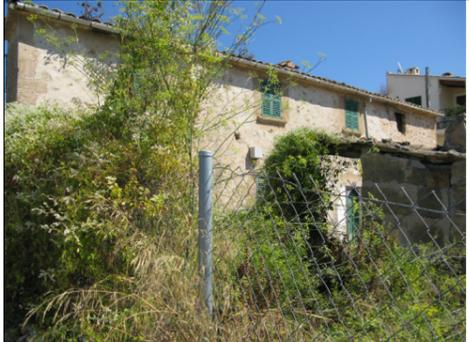
Descripción: Vista de la fachada principal, que no se puede ver completa debido a la vegetación. Tiene dos alturas y cubierta a doble vertiente con teja árabe.
