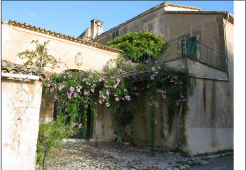
Descripción: Vista de la fachada lateral. El cuerpo principal no tiene vanos. Faltan tejas en la cubierta y hay grietas en los muros. Hay una serie de cuerpos adosado que corresponden a "sa botiga de s'oli", almacenes y un porche, este último en mal estado de conservación.
