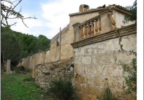
Descripción: fachada del lateral izquierdo con el cuerpo de garaje en el primer plano y del cuerpo de establo. Hay grietas en los muros, la balastrada se ha desprendido parcialmente y las cubiertas están en mal estado.
