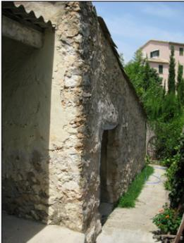
Descripción: Construcciones anexas a la vivienda. La primera esta formada por un poche cubierto con vigas de madera y uralita. La segunda construcción parece ser un almacén y contiene un horno de leña cuya puerta se haya bajo el porche.
