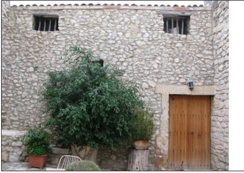
Descripción: La almazara está situada en el lateral derecho del patio. Tiene dos alturas con una puerta adintelada en la planta baja y dos vanos en la planta superior para iluminar y ventilar el interior.
