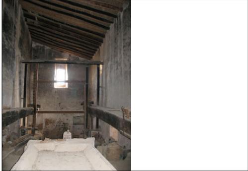
Descripción: Interior de la almazara, con dos alturas y los vanos en la planta superior. El suelo no está empedrado. La cubierta es inclinada, de una vertiente con vigas de madera. No conserva todos los elementos.
