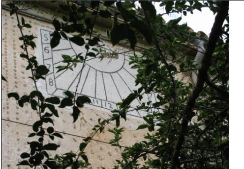
Descripción: el reloj está realizado con mortero de cal y los elementos pintados. En el centro tiene un estil hierro. Alrededor hay un semicírculo del cual surgen los rayos que marcan las franjas horarias. Alrededor una banda con las horas.
